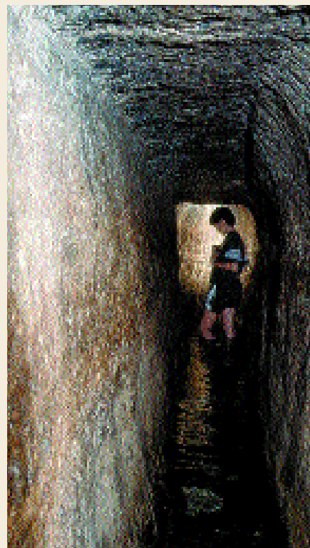
Los trabajadores del rey Ezequías lograron una tremenda hazaña de ingeniería al cavar un gran túnel (a la derecha) a través de la piedra caliza debajo de Jerusalén con el fin de proveer una fuente segura de agua a la ciudad que enfrentaba la invasión asiria. Esta inscripción describe cómo los obreros cavaron por ambos extremos hasta que llegaron a la mitad y terminaron así la monumental obra.
